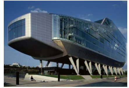
ING Hoofdkantoor Meyer en Van Schooten Architects (MVSA) 阿姆斯特丹, 2002
