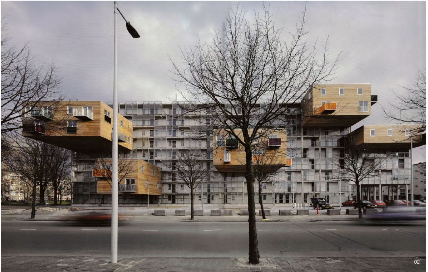
01. SILODAM公寓。项目所在地本是一座水坝和谷仓，被MVRDV改造成可以容纳157户的公寓楼，集住宅、办公、商业和公共空间于一体，满足了低收入群体的需求。阿姆斯特丹，2003 02. WOZOCO老年公寓。该项目是MVRDV完成的第一幢住宅。按照常规设计，该处地基不能满足100套单元房的需求，但MVRDV通过大尺度悬挑结构达到了这一要求。阿姆斯特丹，1997
