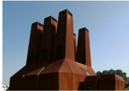
WKK Energy Plant Liesbeth van der Pol, Dok Architecten 乌特勒支, 2005
